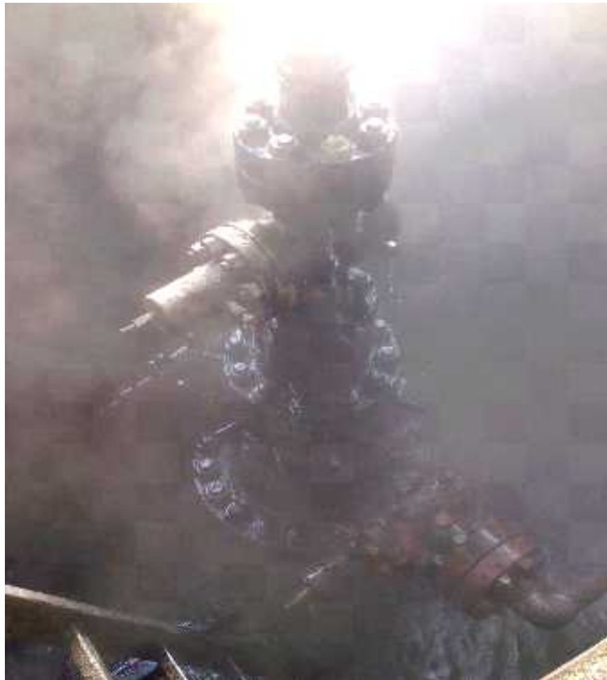
La testa-pozzo a fine lavori del Pozzo “Lignano” (foto Gennaio 2011)
